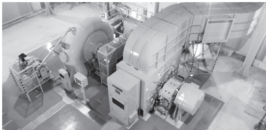
発電機更新を手掛けた東北電力の木戸川第一発電所
