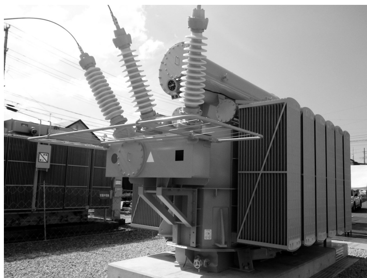
累計納入台数500台を達成した 菜種油入変圧器
